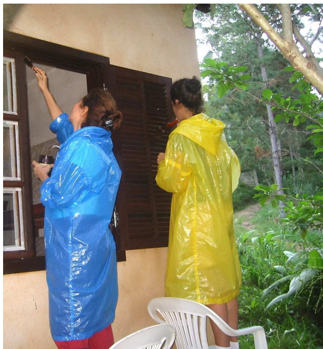
Dormitório feminino: Proteção das janelas com verniz
