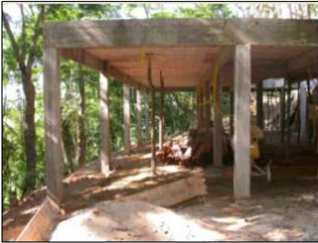
Construção do dormitório masculino, Dhamma Santi Miguel Pereira, 2006
